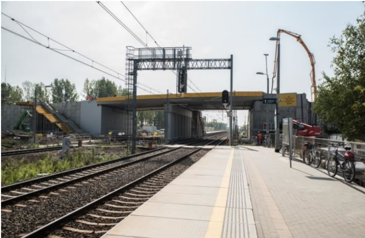
Linia kolejowa nr 8, p.o. Warszawa-Jeziorki, ul. Karczunkowska (fot. Grzegorz Sędziół)
